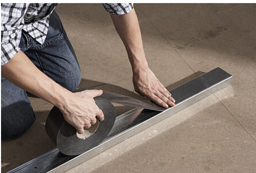
Foto: Knauf Bauprodukte
