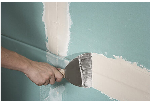
Foto: Knauf Bauprodukte
