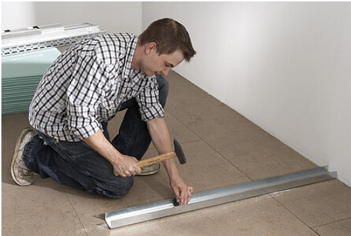
Foto: Knauf Bauprodukte
