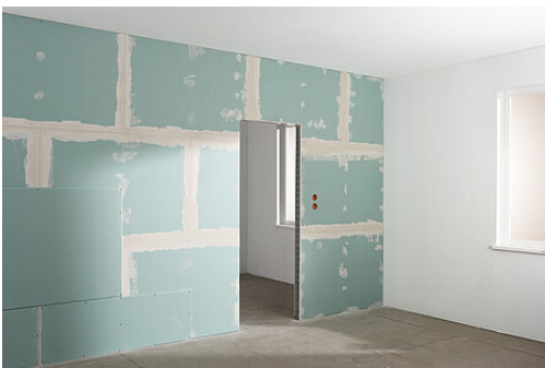
Foto: Knauf Bauprodukte
