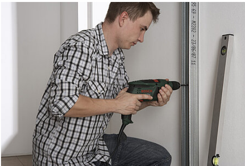
Foto: Knauf Bauprodukte
