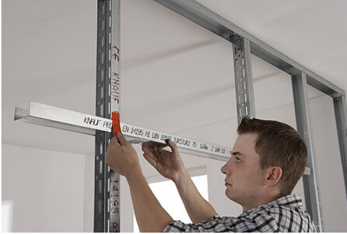
Foto: Knauf Bauprodukte
