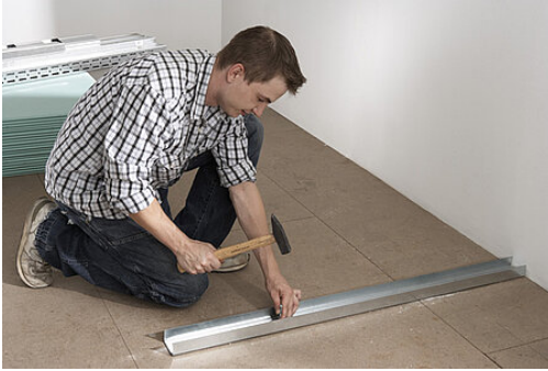
Foto: Knauf Bauprodukte
