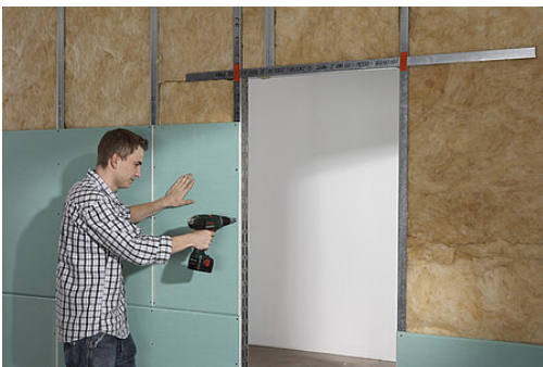
Foto: Knauf Bauprodukte
