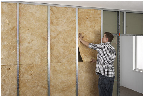
Foto: Knauf Bauprodukte
