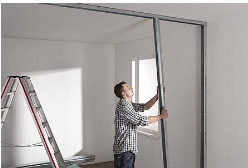
Foto: Knauf Bauprodukte
